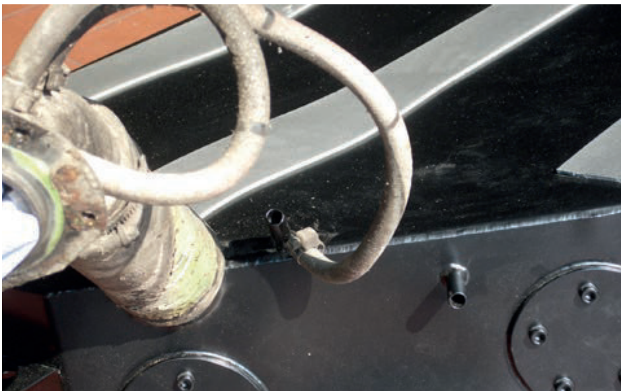
Einfüllrohr an Tank neu
